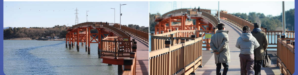
▲ 마파마을과 송여자마을을 잇는 여자도 해상인도교
